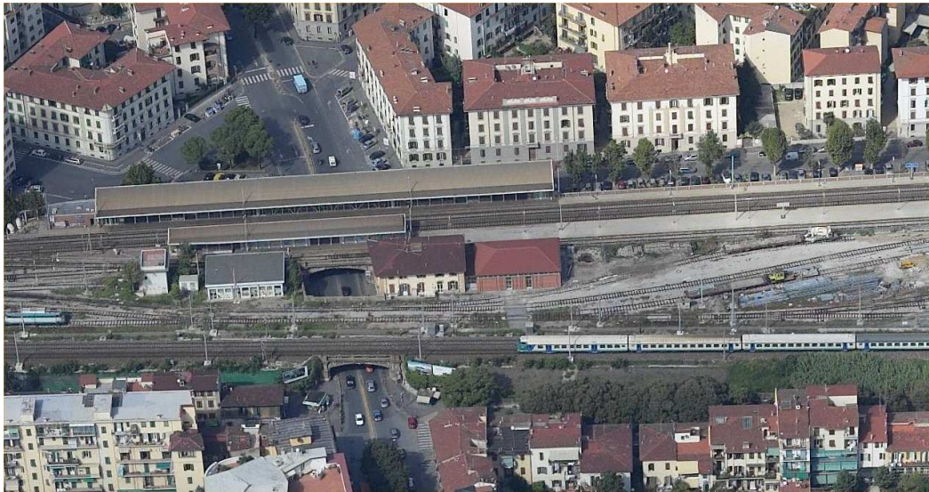
Figura 5. Panoramica del sito di misura di Firenze Statuto.
